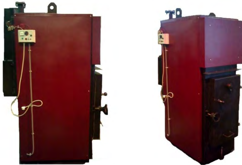
Рис. 5.18. Котел побутовий водогрійний Ardenz T100, що працює на дровах та паливних брикетах
