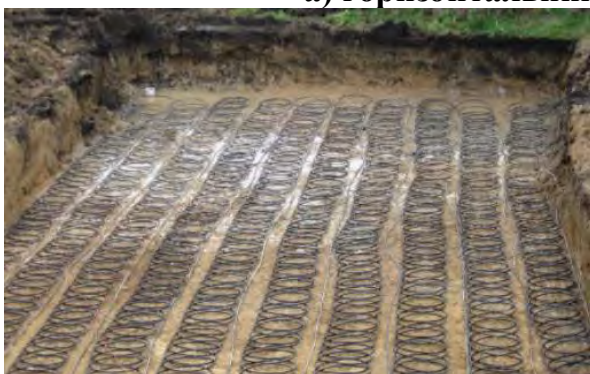
б) спіральний колектор
