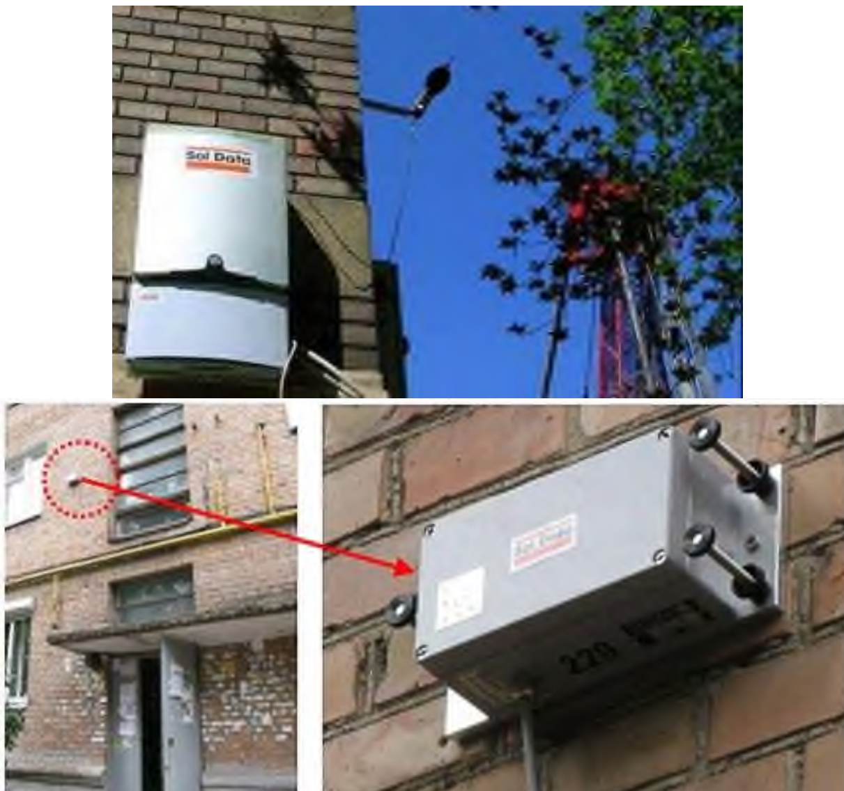
Рис. 2.5. Тривісний геофон акусто-сейсмічного моніторингу системи «Горгона», встановлений по проспекту Перемоги в м. Києві, що виконує вимірювання рівня вібрацій і шуму внаслідок будівельних робіт
