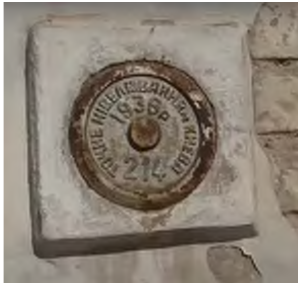
Стінний репер нівелювання (вул. Темірязевська, 3)
