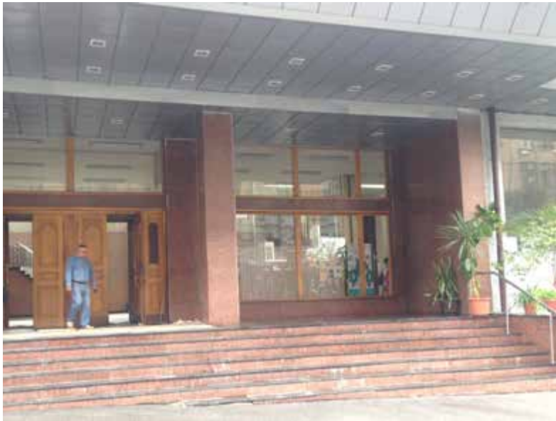
Рис. 3.38. Вхідна група будівлі корпусу літери «Б» в осях «3–5»
