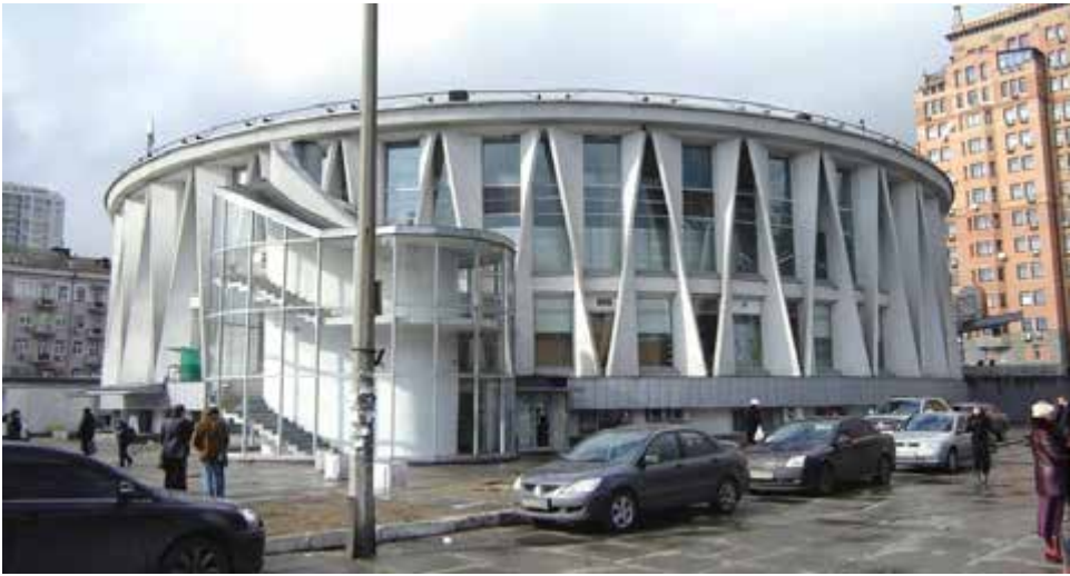
Рис. 12.10. Приклад будівлі з висячою системою покриття залу діаметром 51,8 м із радіально розташованими вантами. Універсам на Печерську, м. Київ, 1982 р., арх. А.М. Аніщенко
