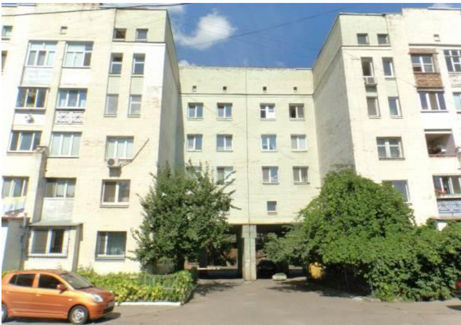
Рис. 3.11. Фрагмент дворого фасаду будинку в осях «13–11», деформаційний шов
