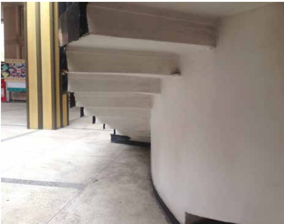
Рис. 3.46. Спирання монолітних залізобетонних східців трапецієвидної форми в плані на криволінійну балку між осями «2-4», «В-Г», на позн. -1,100...±0,000
