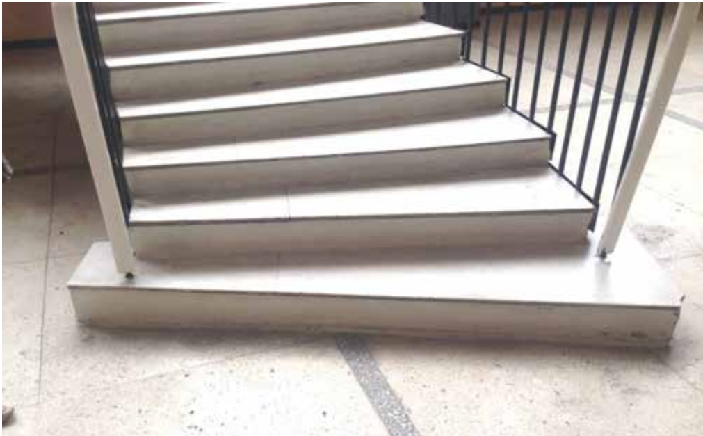
Рис. 3.44. Спирання нижнього схода на монолітну залізобетонну плиту між осями «3–4», «В–Г», на позн. –1.100
