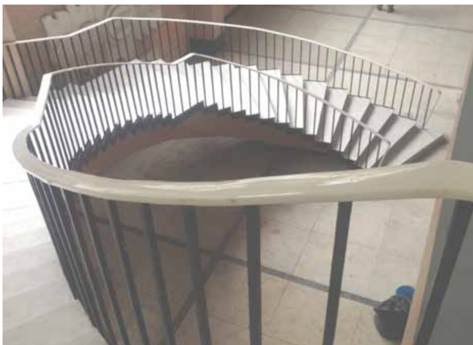
Рис. 3.41. Монолітні залізобетонні сходи з забіжними східцями в осях «2-4», «В-Г», на позн. -1.100
