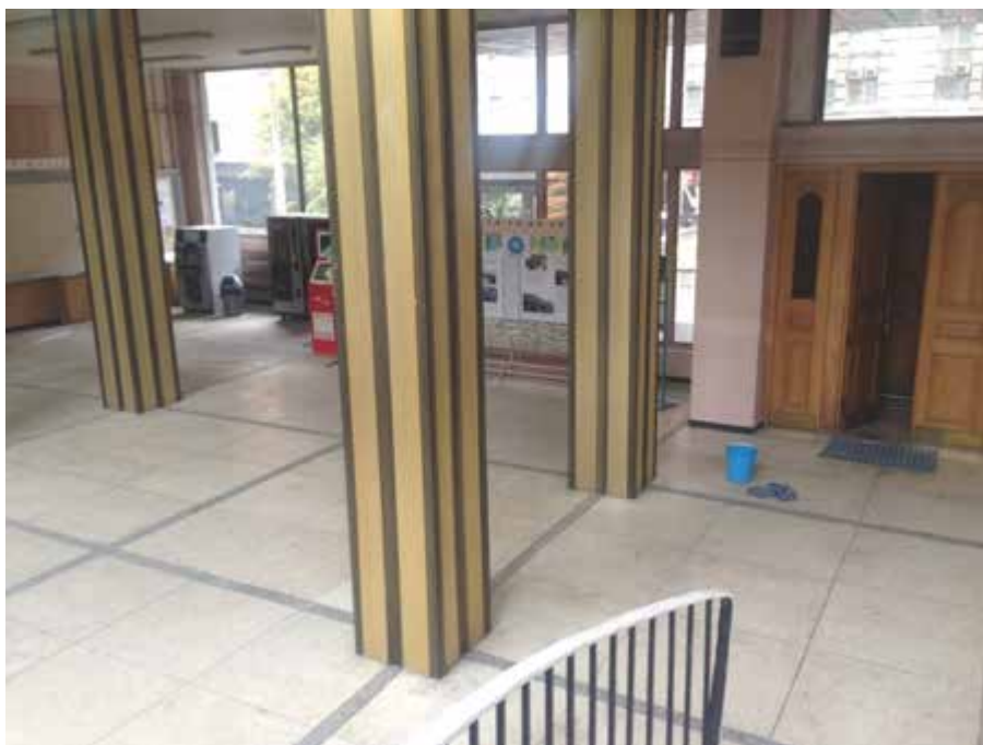
Рис. 3.40. Приміщення вестибюлю будівлі в осях «3-5», «А-В» на позн. -1,100
