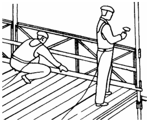
Рис.3.5. Встановлення елементів огороження
