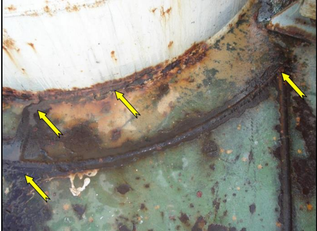
Рис. 11 Приклад корозійного пошкодження зварних швів нижньої частини дверей
