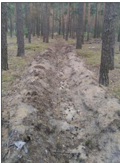
Рис. 4.14. Приклад мінералізованої смуги для зупинки низових пожеж
