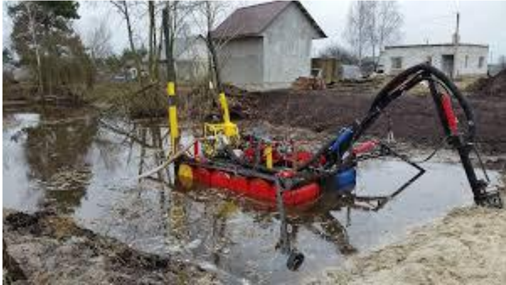
Рис.1.5 Механізоване очищення водойми від надлишкових мулових нашарувань із застосуванням земснаряда.
