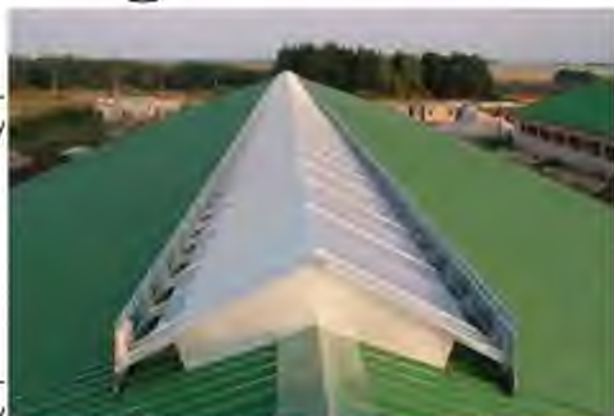
Рис. 4.2. Конструкція світлового вікна (коника) та світло-аераційного коника на даху корівника
