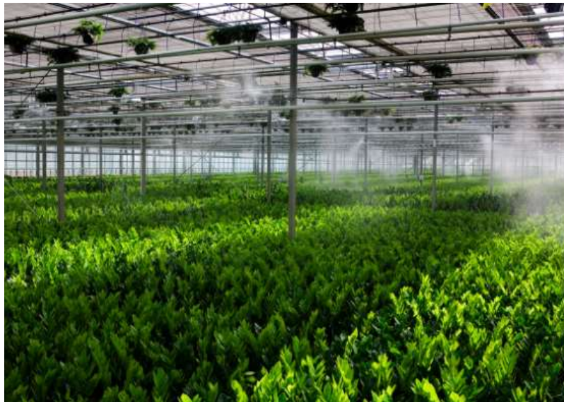
Рис.1.6. Система туманоутворення реалізована на одному з провідних підприємств по вирощуванню квітів
