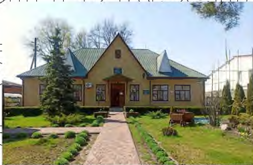
Рис. 2.1. Адміністративна будівля ДП «Пирятинське ЛГ»
