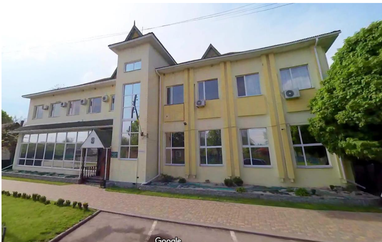
Рис. 3.1. Адміністративний будівля Миргородського надлісництва
