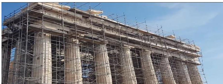
Рисонок 2 – Армування конструкцій будівлі
