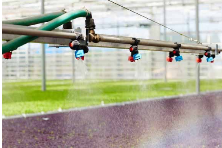
Рис. 3.11 Приклад використання підвісних спринклерів в теплиці
