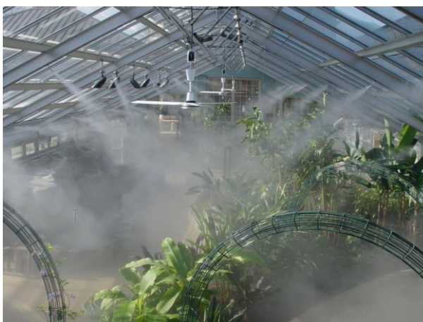
Рис. 3.13 Використання системи туману в умовах посушливого клімату
