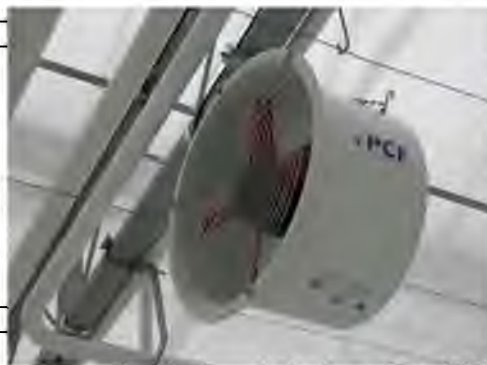
Рис. 2.8. Система осьового вентилятора для циркуляції картоплі
