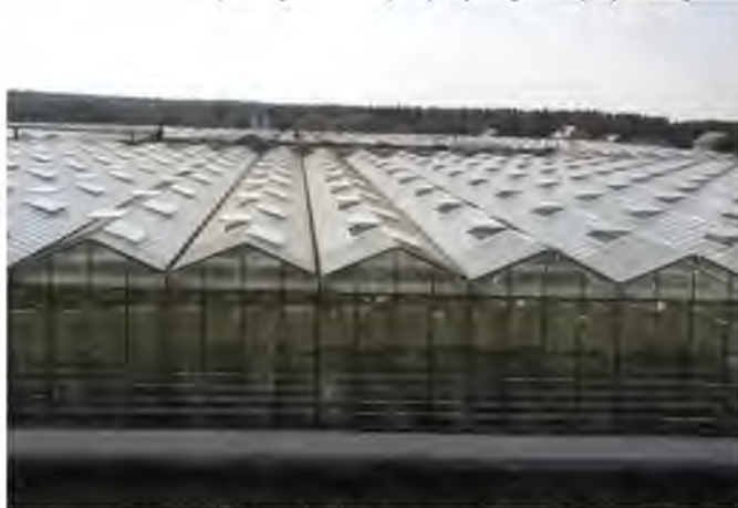
Рис. 2.4. Блок вентиляційної системи опалення
