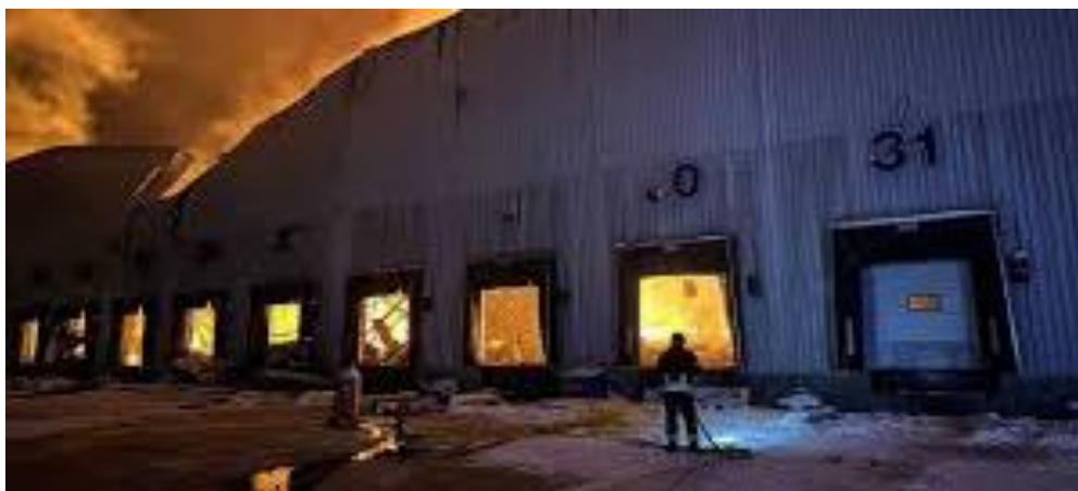
Рис. 1.10. Зруйноване складське приміщення внаслідок ворожої атаки
