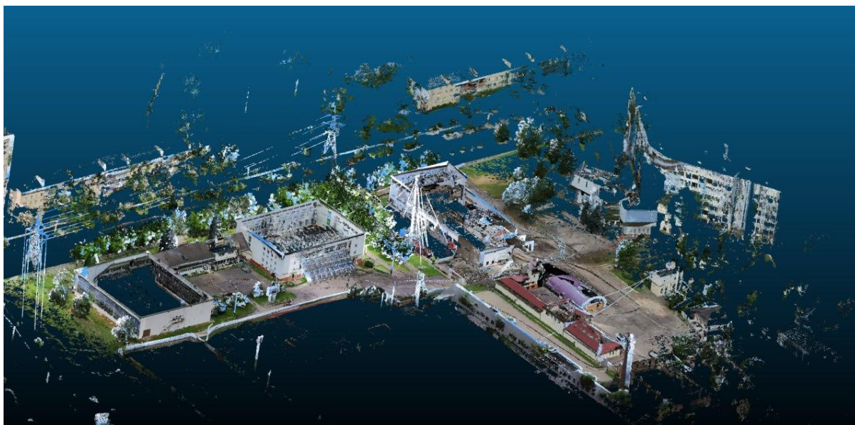
Рис. 2 Кольоризована хмара точок пошкоджених будівель ІФНТУНГ
