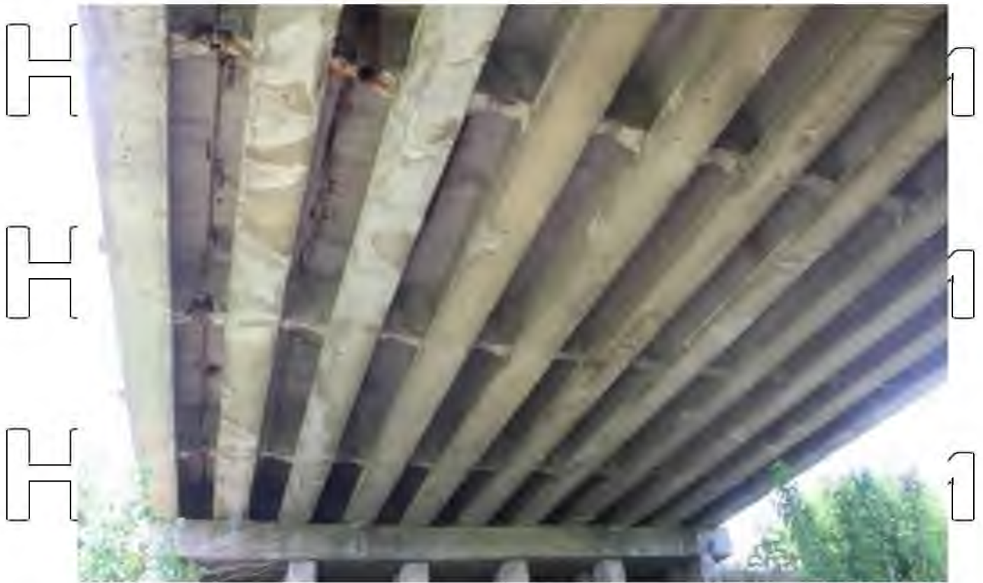
Рисунок 7.3 – Вид на прогонову будову моста 0-1
