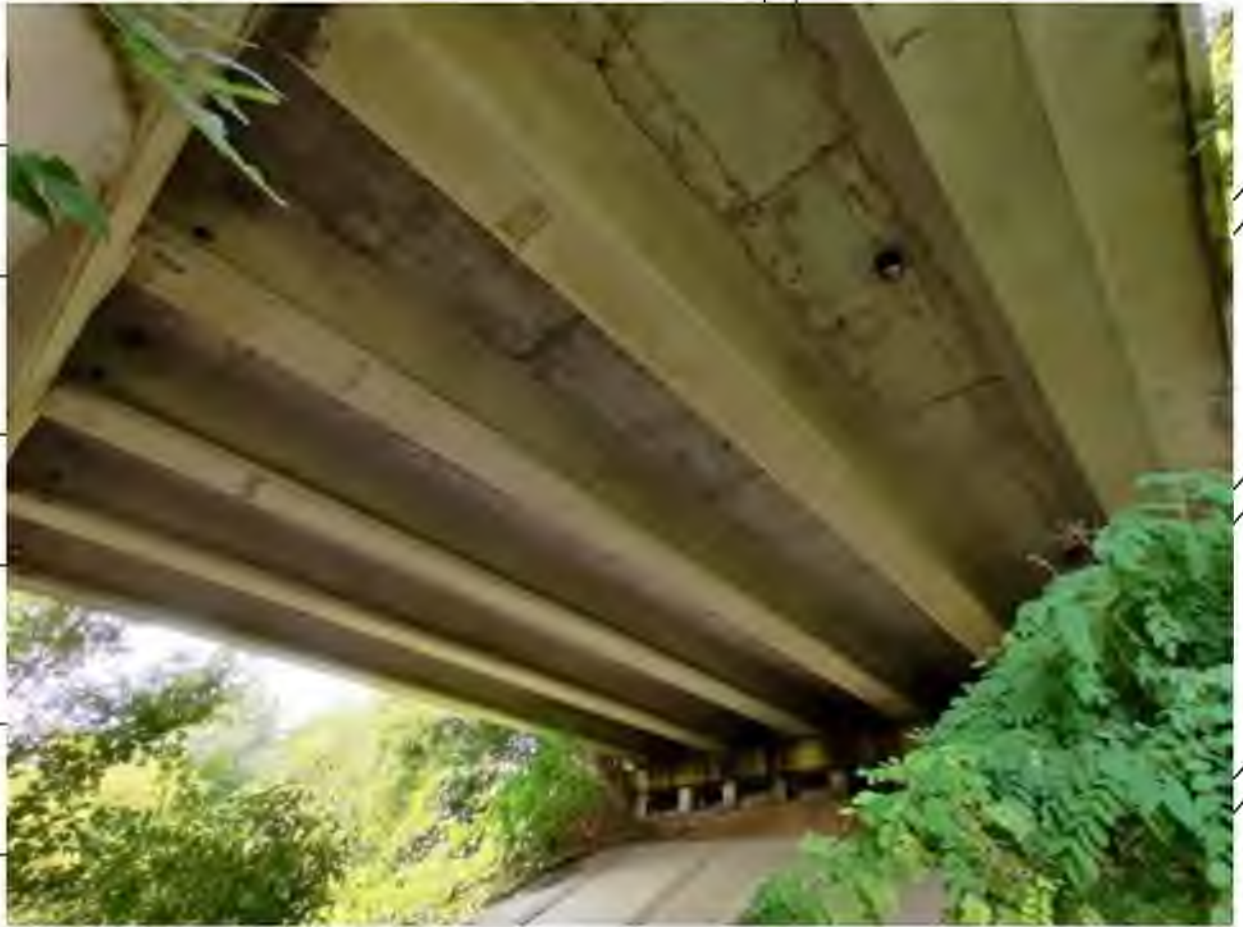
Рисунок 7.4 – Вид на прогонову будову 1-2
