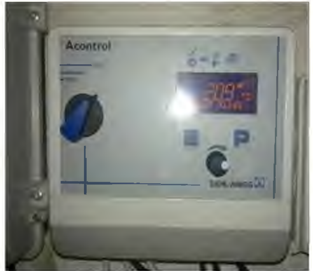
Вентиляційна шахта та комп'ютерний блок управління параметрами мікрокліматом у приміщеннях для утримання свиней
