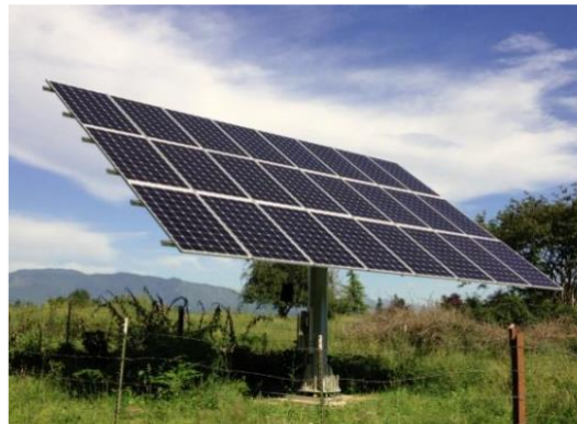
Рис. 2.4. Трекер типу TTDAT
