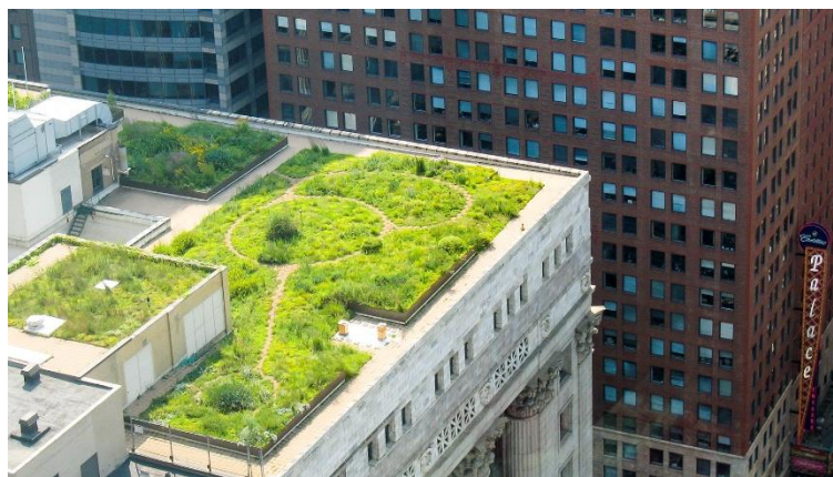
Рис. 1.3. City Hall Green Roof у Чикаго [29]
