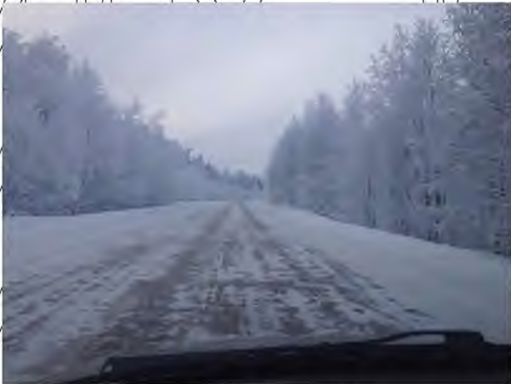
Рис. 5.1 Експериментальна ділянка лісовозної автомобільної дороги з покриттям у вигляді снігового накату
