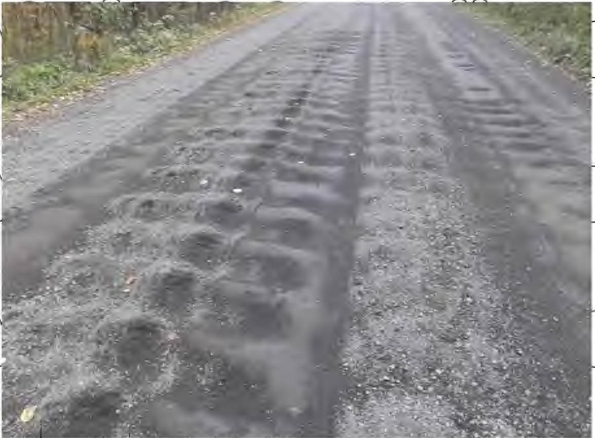
Рис. 5.9 Гребінка на лісовозній автомобільній дорозі з покриттям із відсіву дроблення
