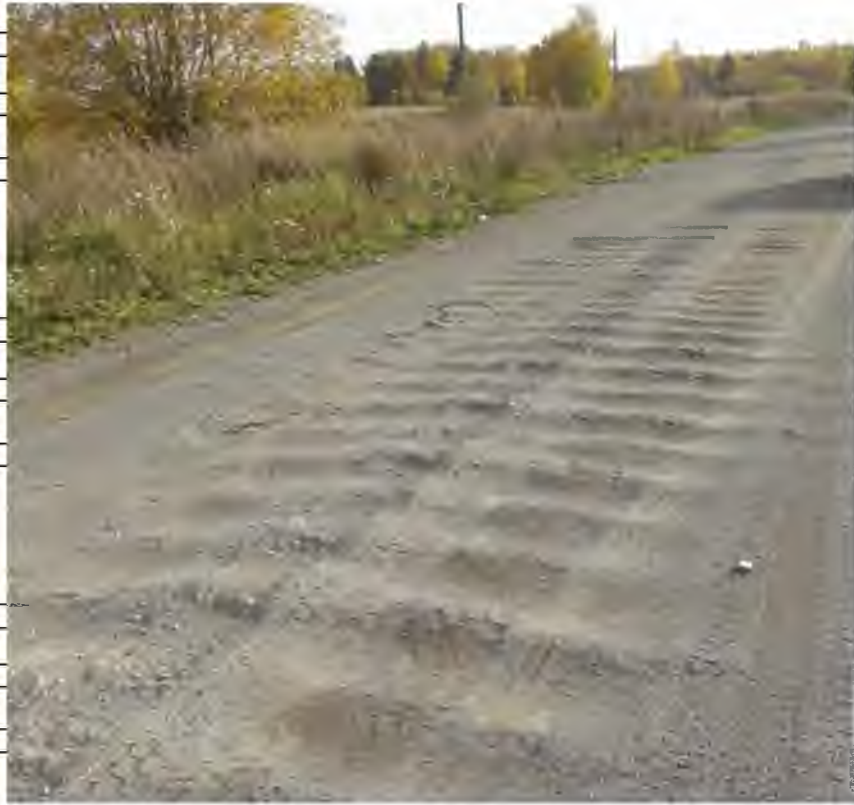
Рис. 5.7 Гребінка на лісовозній автомобільній дорозі
