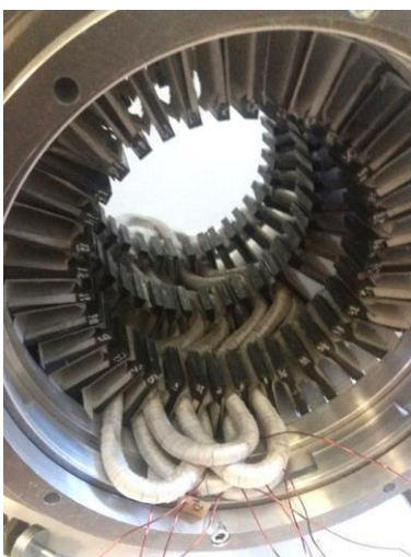
Рис. 5.21. Укладка обмотки якоря ГПСБР
