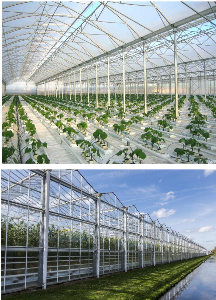
Рисунок 1.1 – Загальний вигляд теплиці
