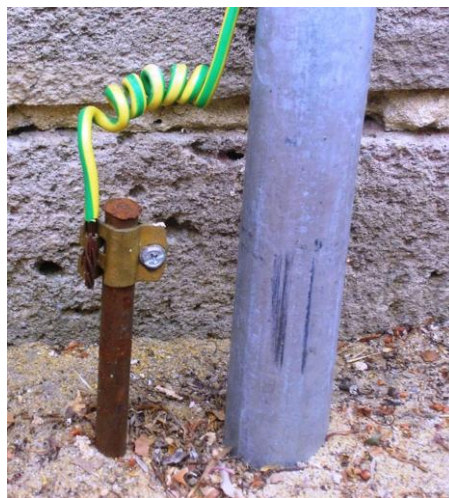
Рис. 9.1. Заземлюючий пристрій
