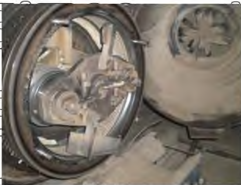
Рис. 5.2. Проведення щозмінного технічного огляду вузла пелетування
