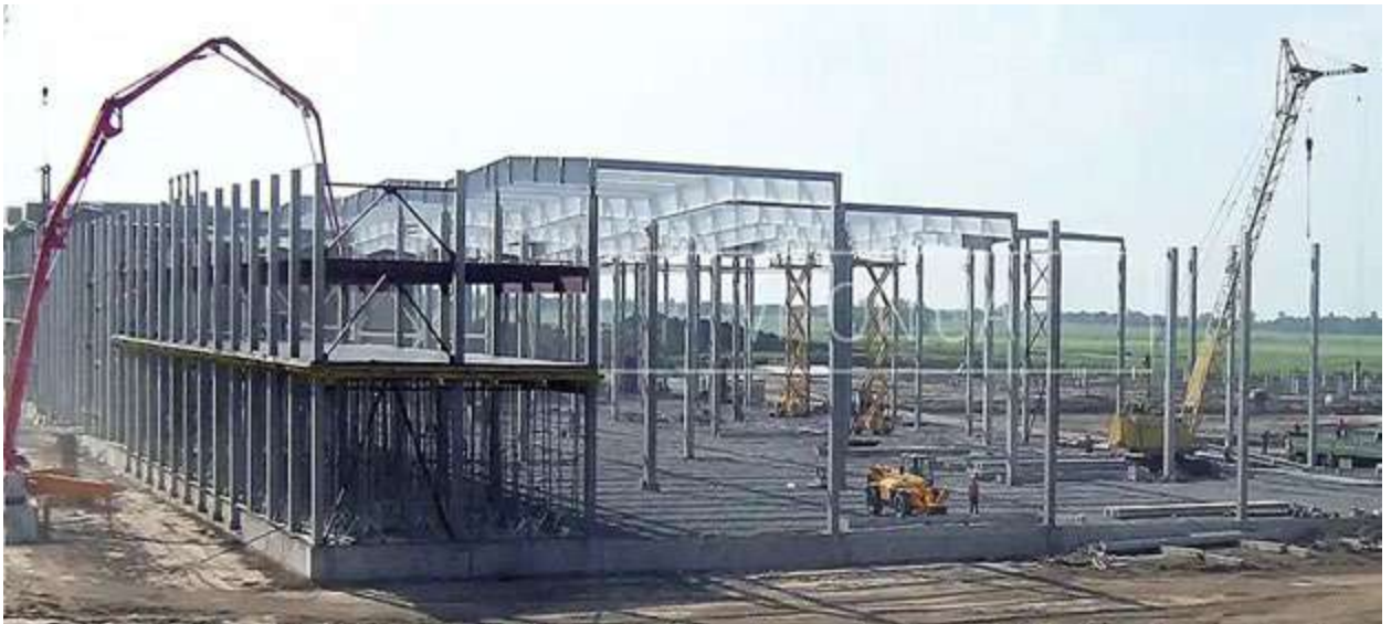
Рис. 2. Зведення торового центру за техноогією ЛМК
