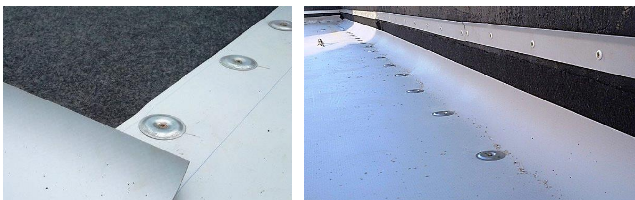
Рис. 5.3. Встановлення кріпильні елементів
