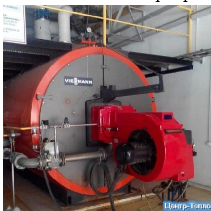
Рис. 1.14. Водогрійний котел Viessmann типу Vitomax 200
