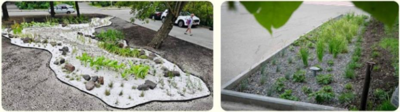
Рис. 3.6. Фільтрація дощової води (фото автора)
