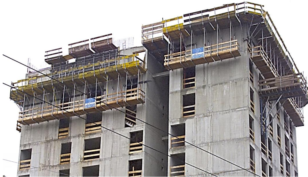
Рис. 6.2. Підйомна - переставна опалубка рамного типу відповідає стандарту DIN 4420 та правилам техніки безпеки (UVV галузевої асоціації), захисні помості за стандартом DIN 4420-1
