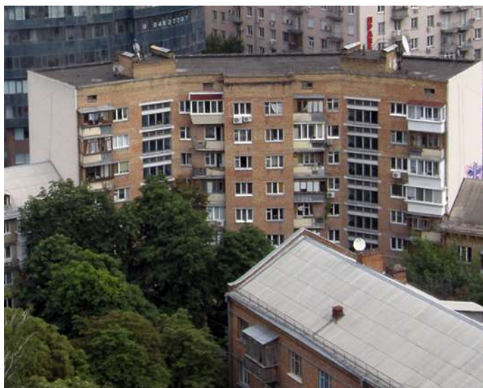
Рис. 4.1. Багатоквартирний житловий будинок на Кловському узвозі м. Київ [21]
