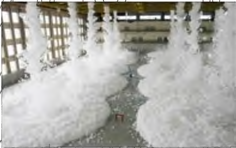
Рисунок 1.4 – Робота порошкової СП
