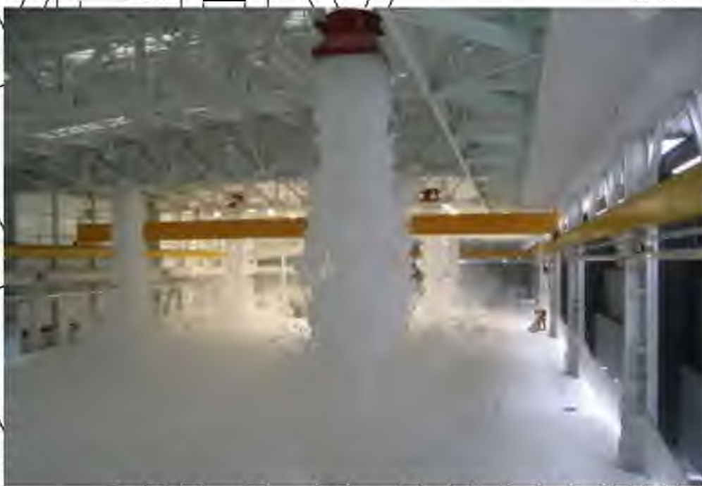
Рисунок 1.5 – Робота пінної СП
