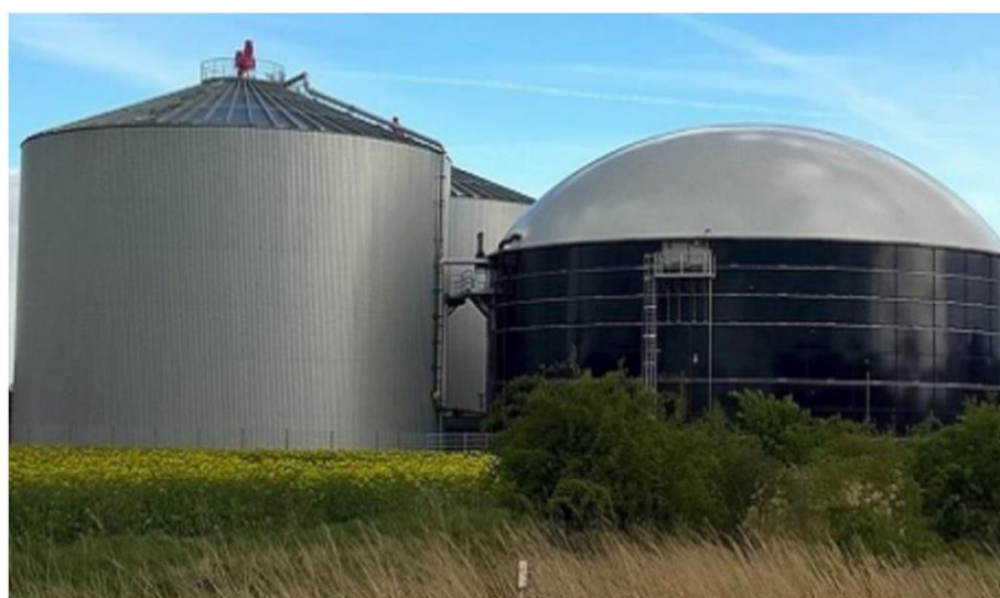
Рисунок 3. 6 – Газгольдер
