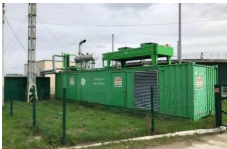
Рисунок 3.7 – Когенераційна установка
