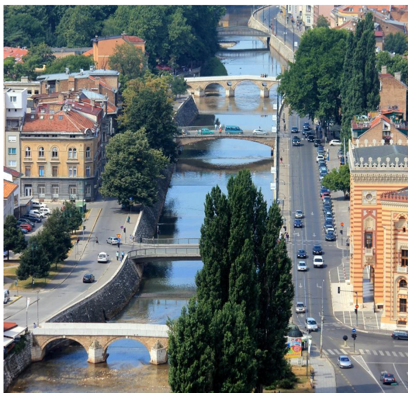
Рис. 3.8. Відновлена набережна річки Міляцки [13]
