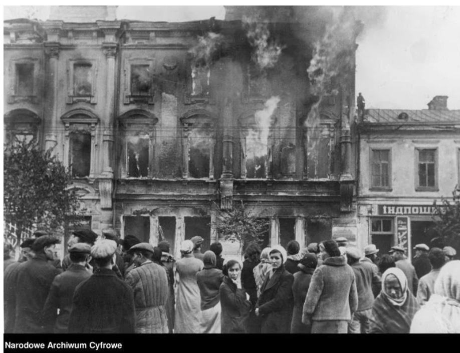
Рис. 3.2. Зруйнований Хрещатик, 1941 рік [10]
