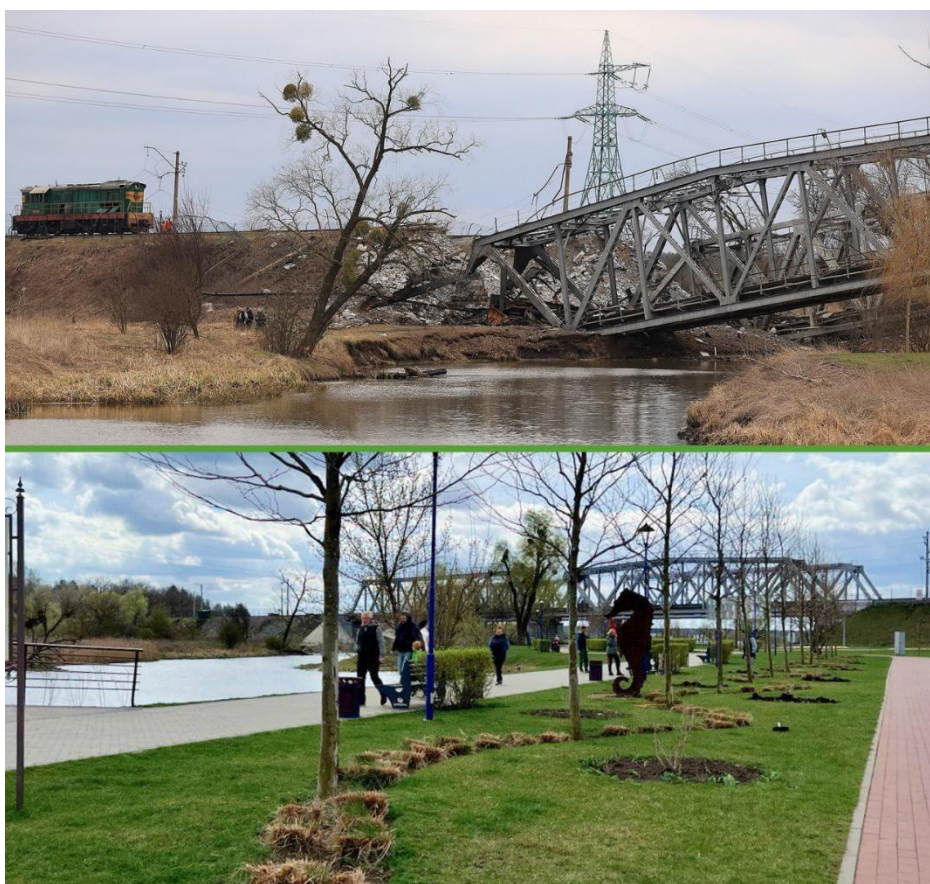
Рис. 2.10. Пошкоджена та відновлена набережна Ірпеня [8]
