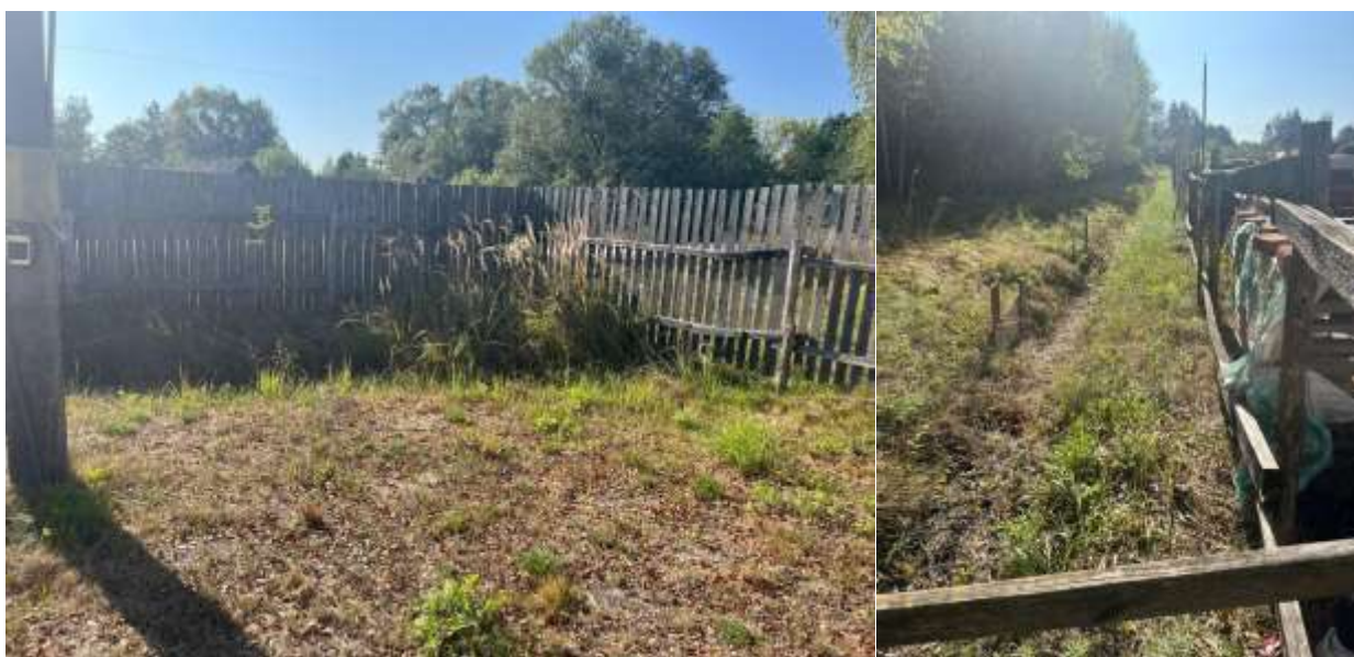
Рис. 2.6. Водозбірний канал (фото автора, липень 2023 р.)
