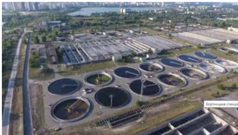
Рисунок 2.3 – Відстійники біологічного очищення стічних вод БСА
