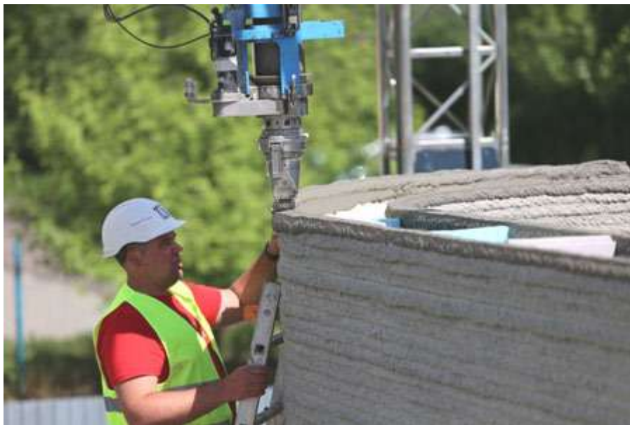
Рис. 2.2. Будівництво навчального закладу у Львові [7]
