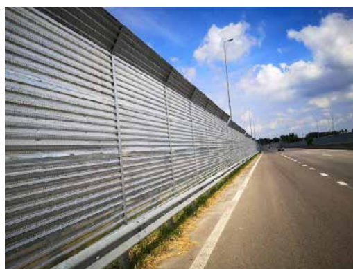
Рисунок 5.1.1. Інженерні рішення для контролю шумового забруднення
