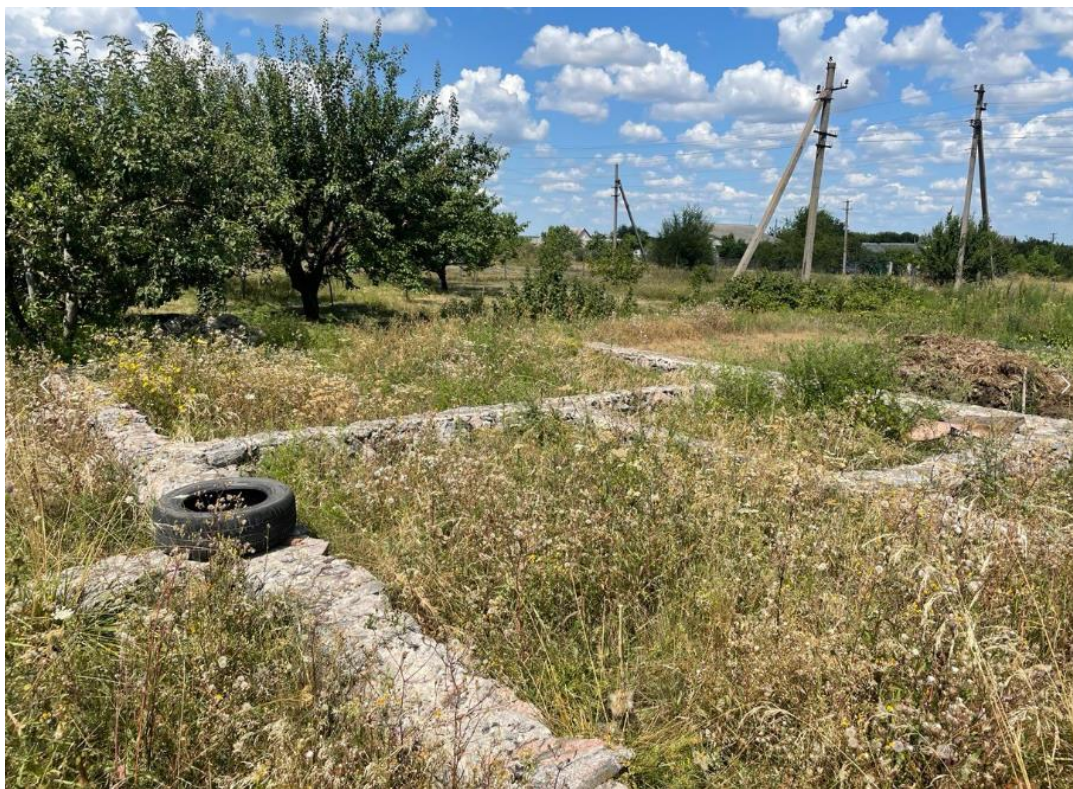
Рис. 2.2. Наявний фундамент будинку (фото автора)
