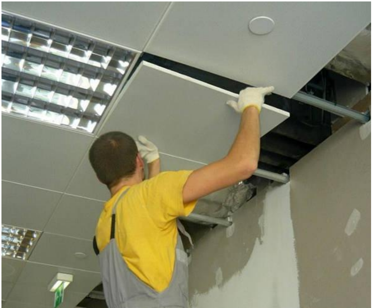
Рис.3.2 Встановлення стельових плит.
