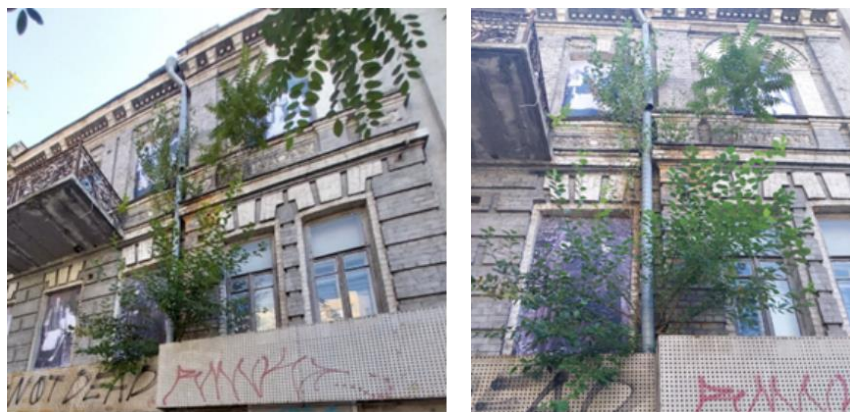
Рис. 3.6. Проникнення рослини через будівельну конструкцію на бульварі Тараса Шевченка, буд. 19 (фото автора, серпень 2025 р. ).
