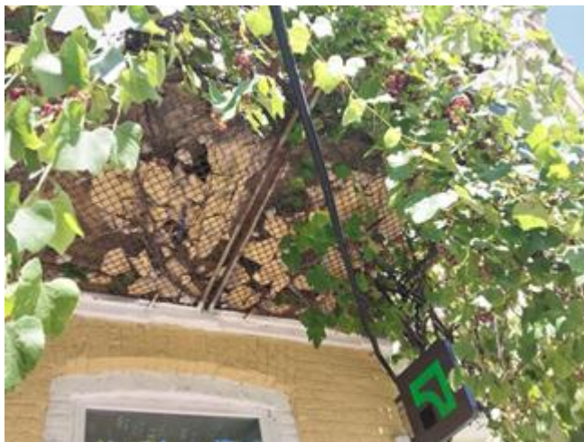
Рис. 3.15. Металева сітчаста конструкція для витких рослин, закріплена під карнизом будівлі (фото автора, серпень 2025 р.).
