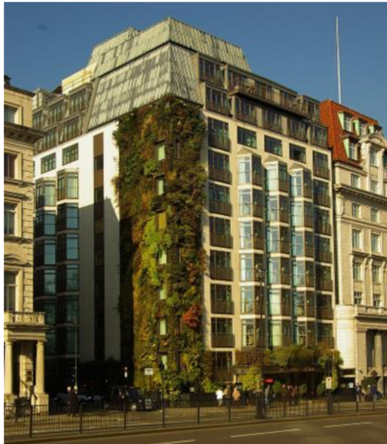
Рис. 1.4. Будівля готелю Athenaeum у Лондоні, Велика Британія [11].
