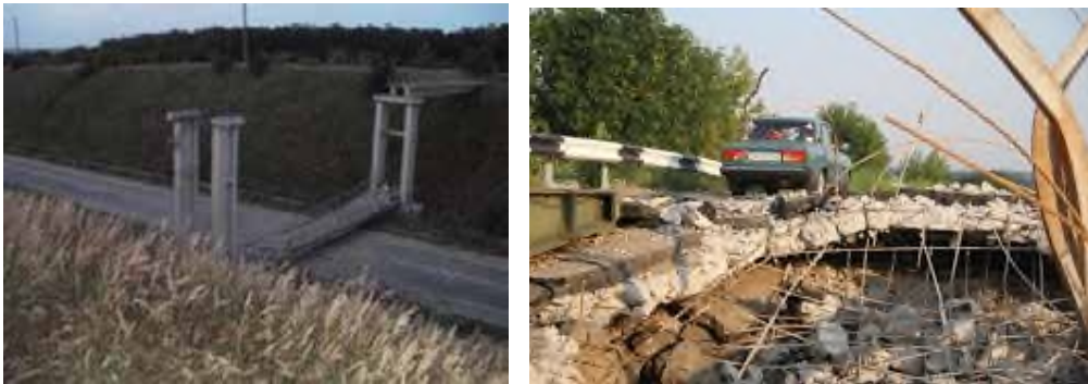
Рис. 3. Пошкоджені автомобільні мости.
