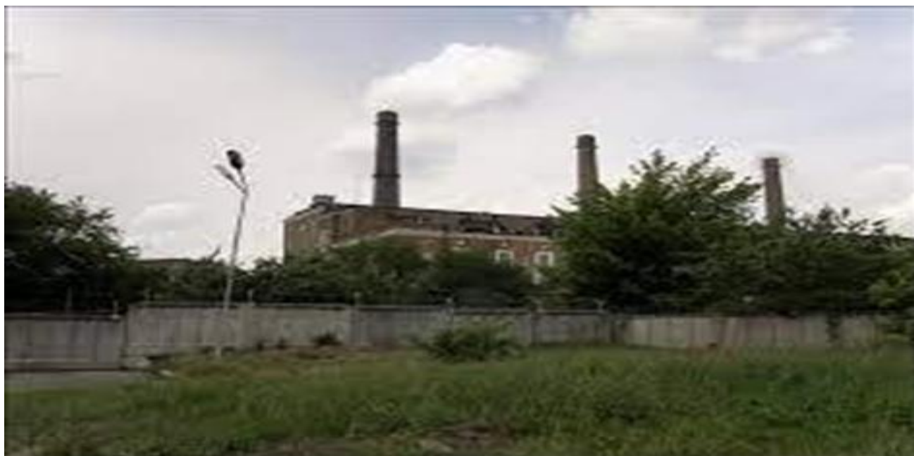
Fig. 2.11. CHP-4 (Darnytska CHP)*
