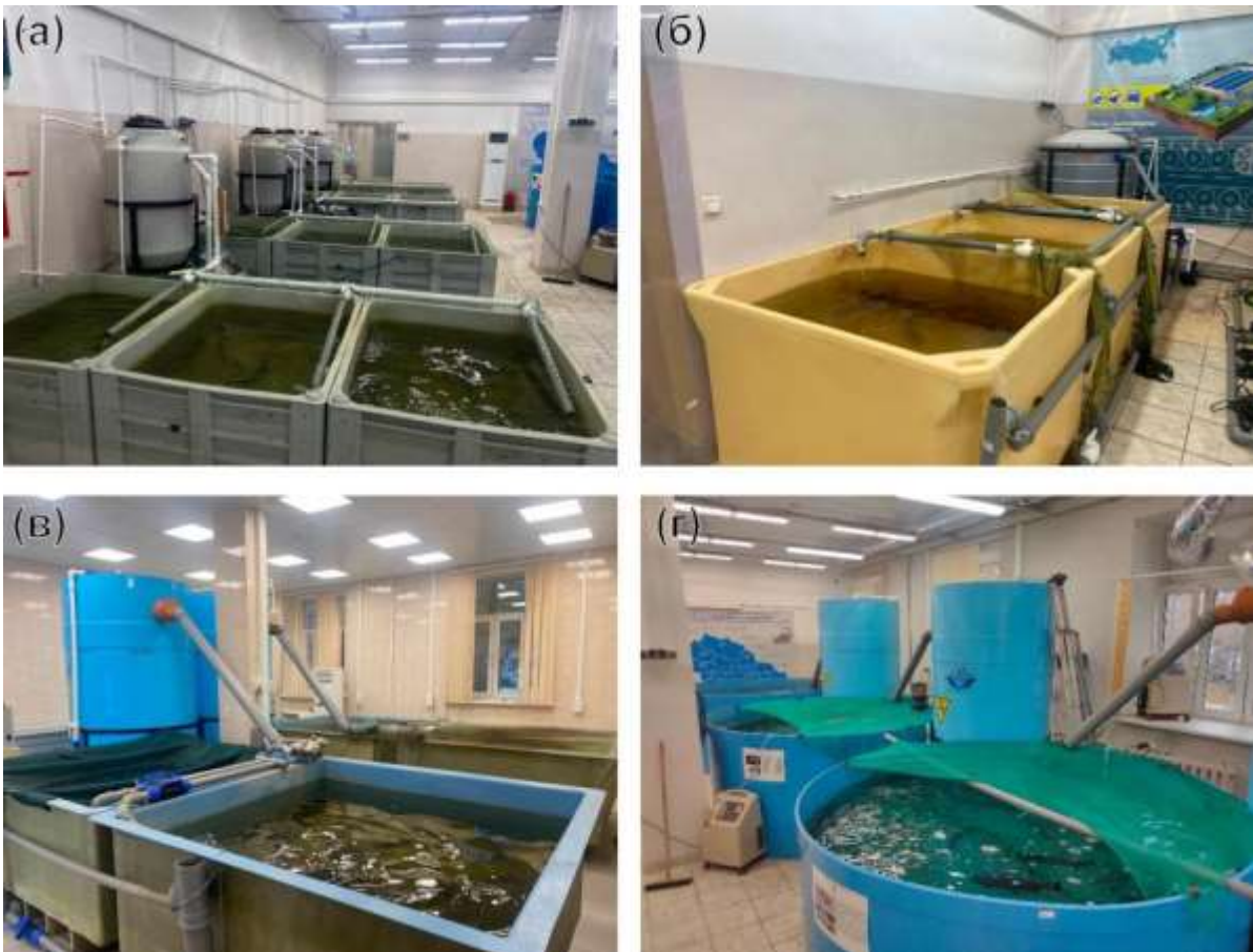
(а, б) – баки для проведення експериментальних робіт, лінія 4+1 з баками об'ємом 750 літрів (усього 12 баків); (в, г) – ємності для утримання риб об'ємом 3000 л
