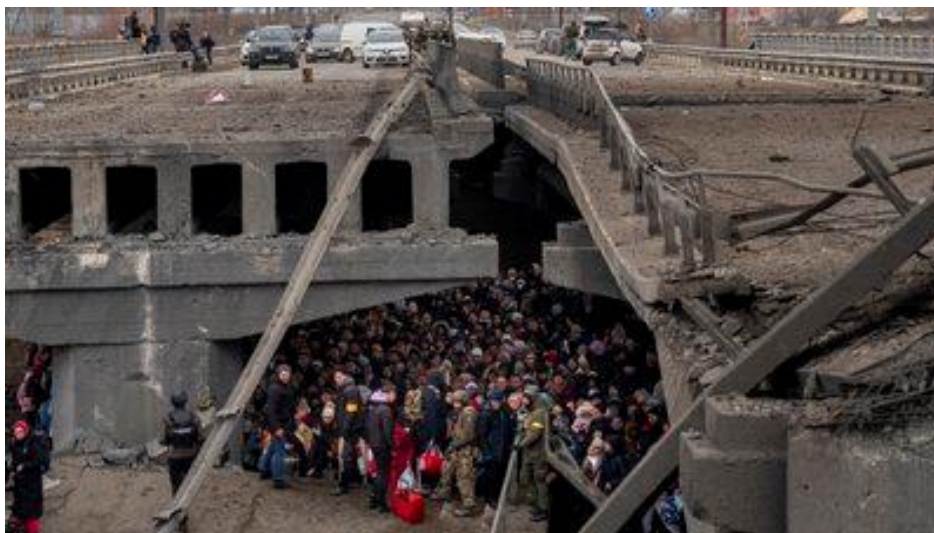
Рис. 1.1. «Дорога життя» – зруйнований міст через р. Ірпінь, яким містяни вибиралися з частково окупованого міста [11].
