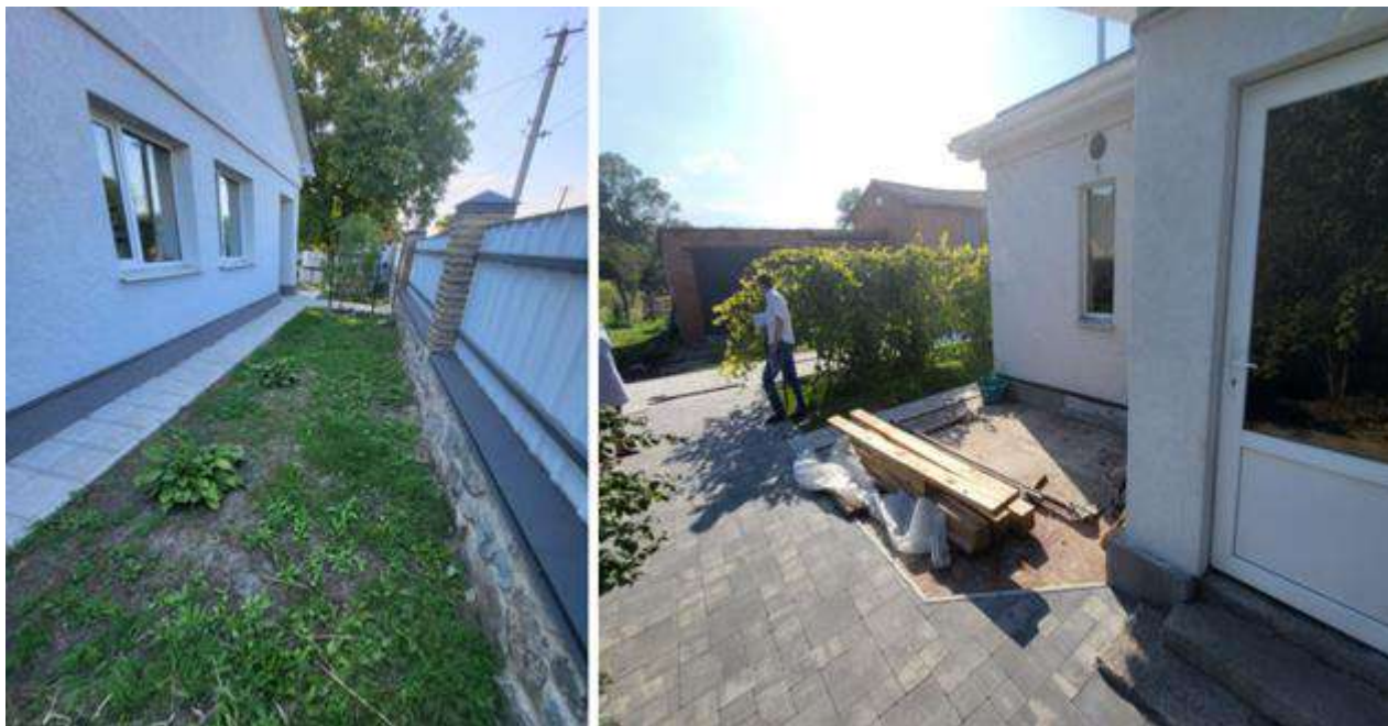
Рис. 3.2. Північно-західний фасад будинку та головний вхід (фото автора)
