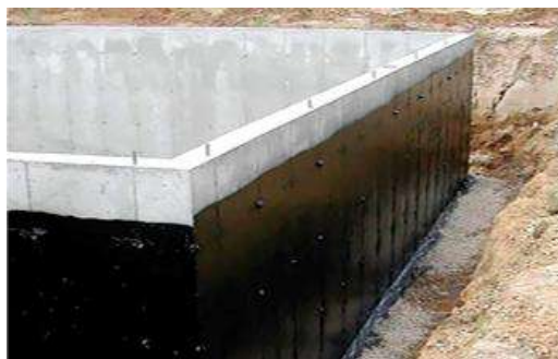
Рис. 5.5. Зовнішня гідроізоляція з бітумної паста або емульсії «Марей»
