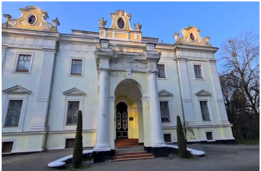
Рис. 2.8. Вид переднього фасаду палацу (фото автора)
