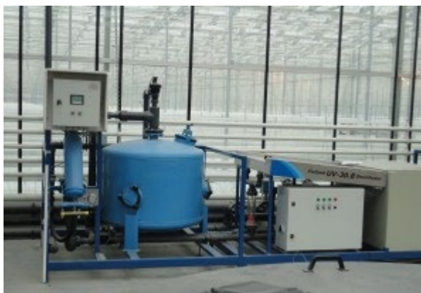
Рис. 1.14. Система знезараження дренажу
