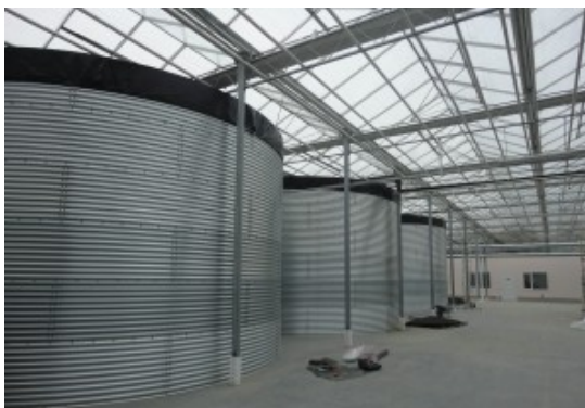
Рис. 1.7. Баки запасу води для приготування розчинів
