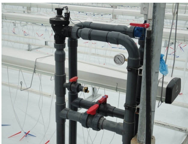
Рис. 1.12. Моторизовані крани для точної дотації крапельного поливу
