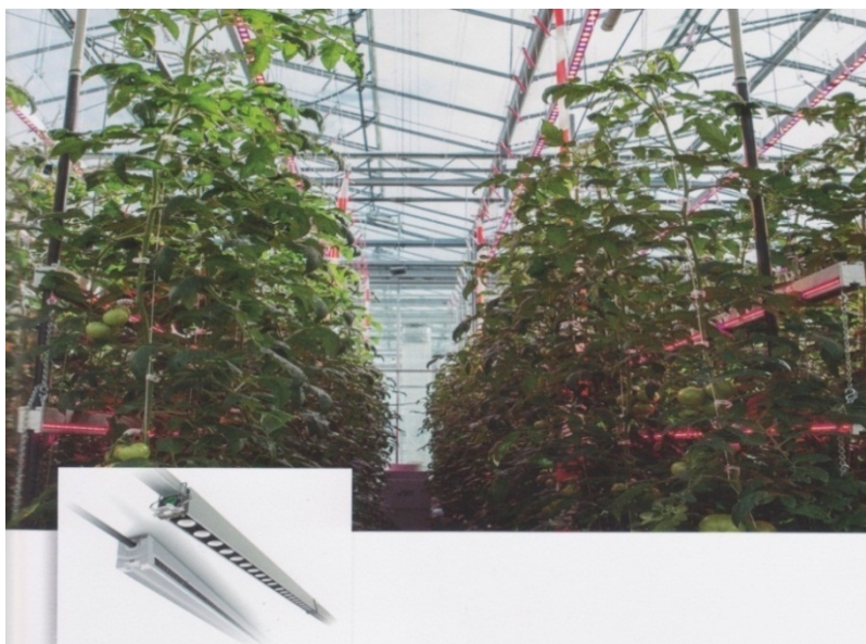
Рис. 1.17. Розміщення LED лам для досвічування помідорів
