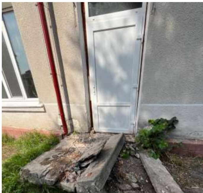
Рис. 3.9. Технічний вхід до будівлі дитсадка (фото автора)
